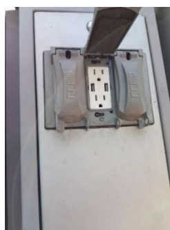
Ilustración 15 Sistema de protección para uso indebido de la corriente del tótem y carga de dispositivos electrónicos de comunicaciones
