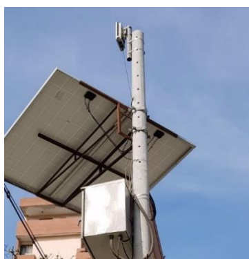
Ilustración 10 Access point principal y secundario
