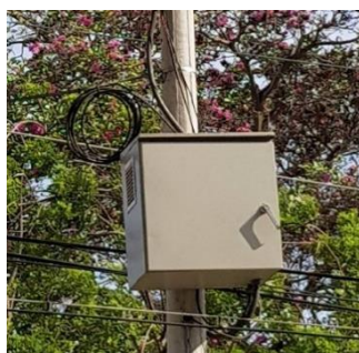
Ilustración 12 Gabinete de networking
