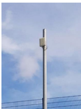
Ilustración 9 Access point principal y secundario
