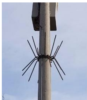
Ilustración 13 Sistema contra robo en postes
